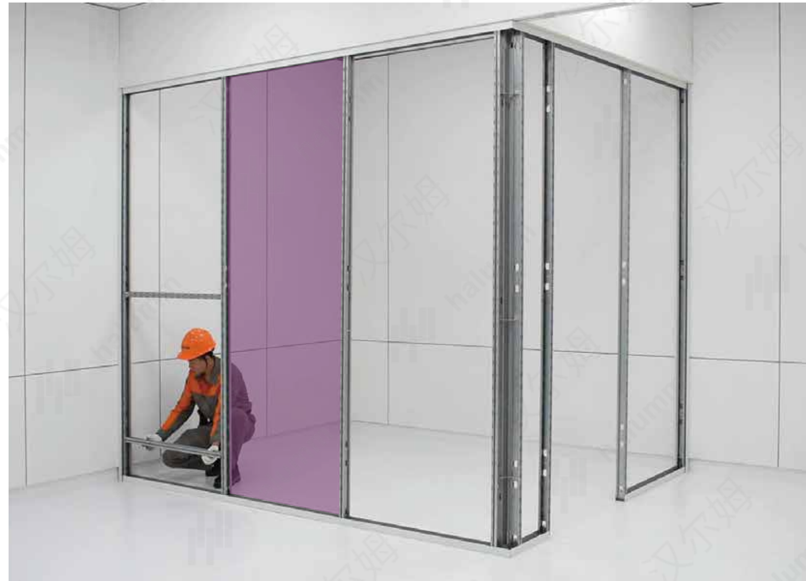
用可去除的胶带安装地板 轨道 Erection of vertical keel
